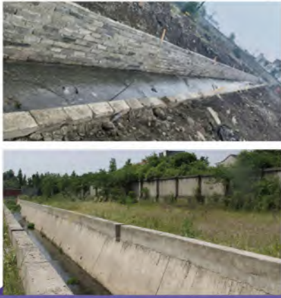
改造后的暗渠
